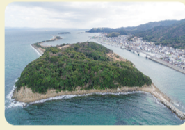
19 紀淡海峡と 由良・成ヶ島 洲本市由良町由良
